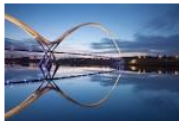
Slika 5. Izgradnja mosta – obrnuta proporcionalnost
